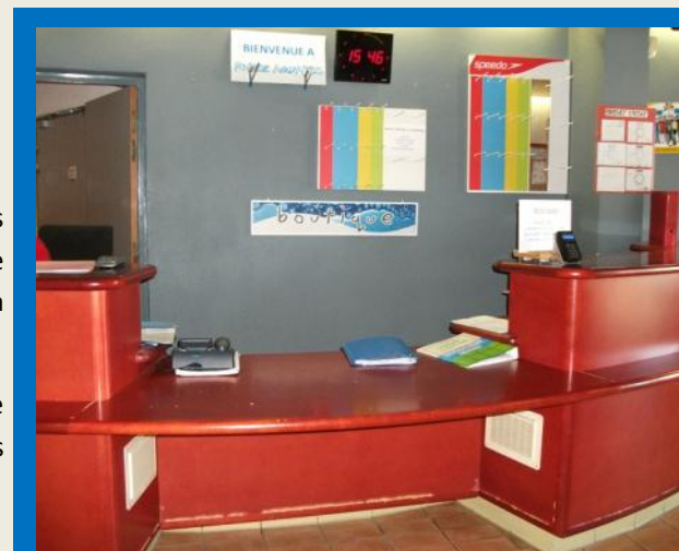
15) Illustration d'une banque d'accueil en partie surbaissée accessible aux personnes en fauteuil roulant, aux enfants et aux personnes de petite taille
